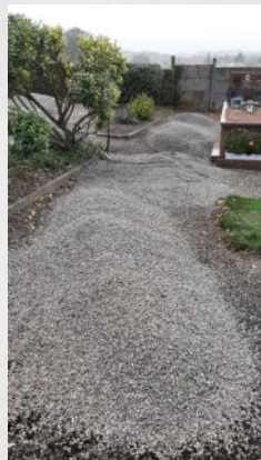
Remise en état des allées du cimetière
