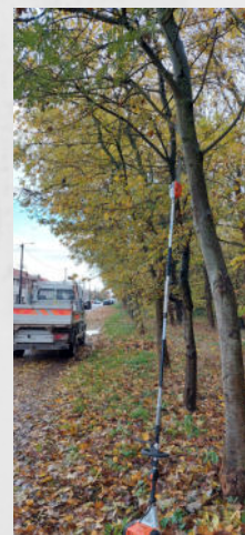
Divers travaux d'élagage dans le village
