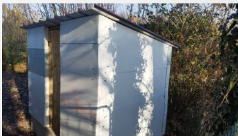
Construction d'un abri pour la cuve à fioul de la salle de musique.
